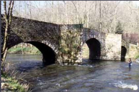
Le Pont Lasveyras sur l'Avézère (MH classé)
