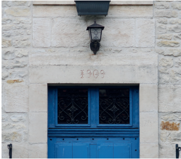
Détail d'une maison : date portée
