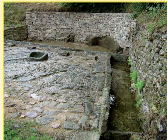
Complexe hydraulique Haute-Faye (Royère-de-Vassivière)
